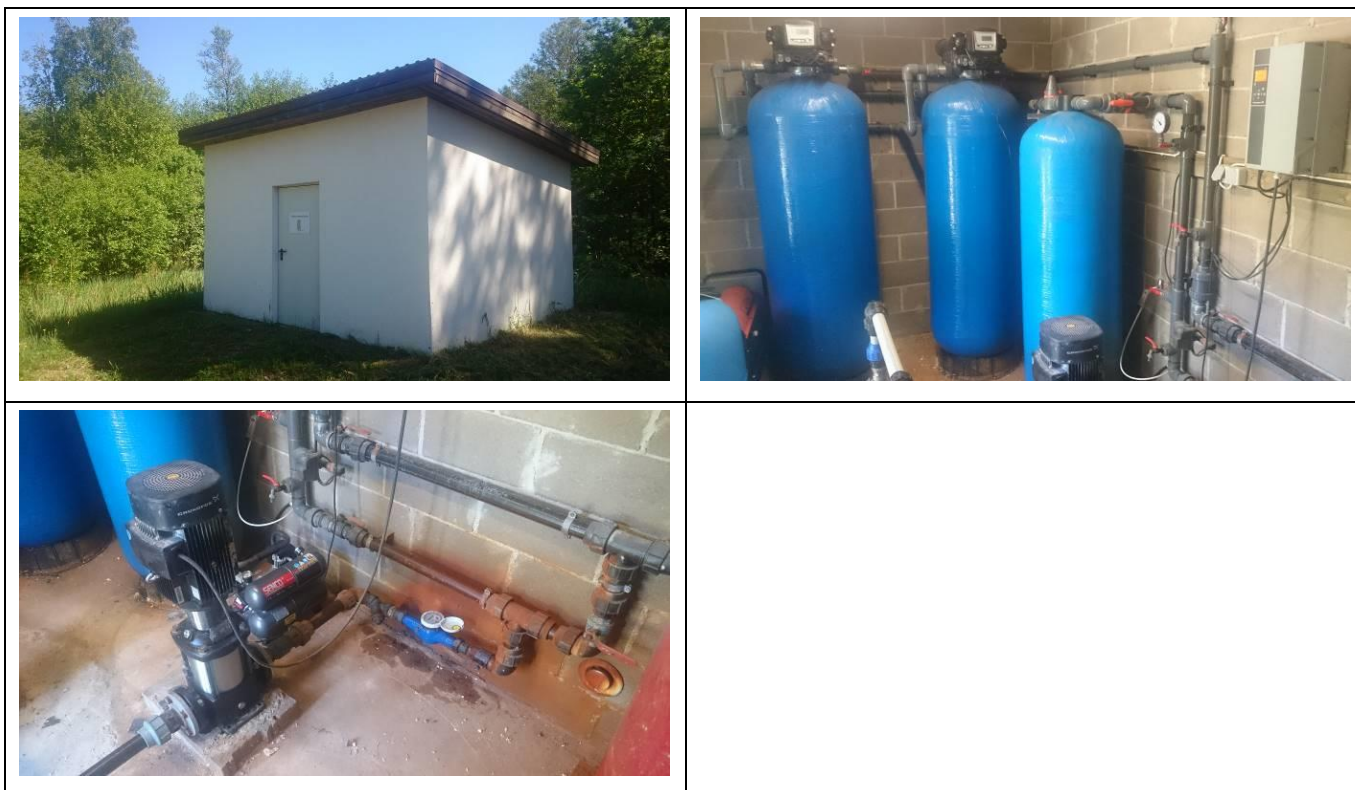
Joonis 3. Häädemeeste aleviku Keskuse puurkaev (katastri nr 6566) ning veetötlusjaam. Fotod: OÜ Alkranel 21.05.2018.
