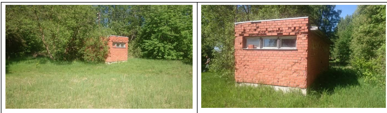
Joonis 6. OÜ Runtzu puurkaev-pumpla (katastri nr 6557). Fotod: OÜ Alkranel 21.05.2018.
