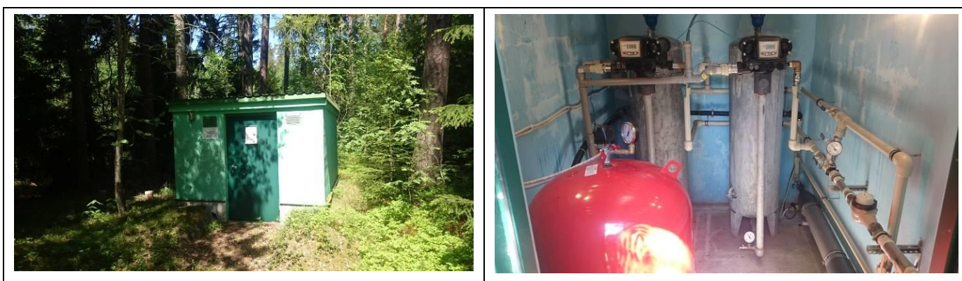
Joonis 16. Reiu küla Suksumetsa puurkaev-pumpla (katastri nr 20069 ning veetötlusjaam). Fotod: OÜ Alkranel 21.05.2018.
