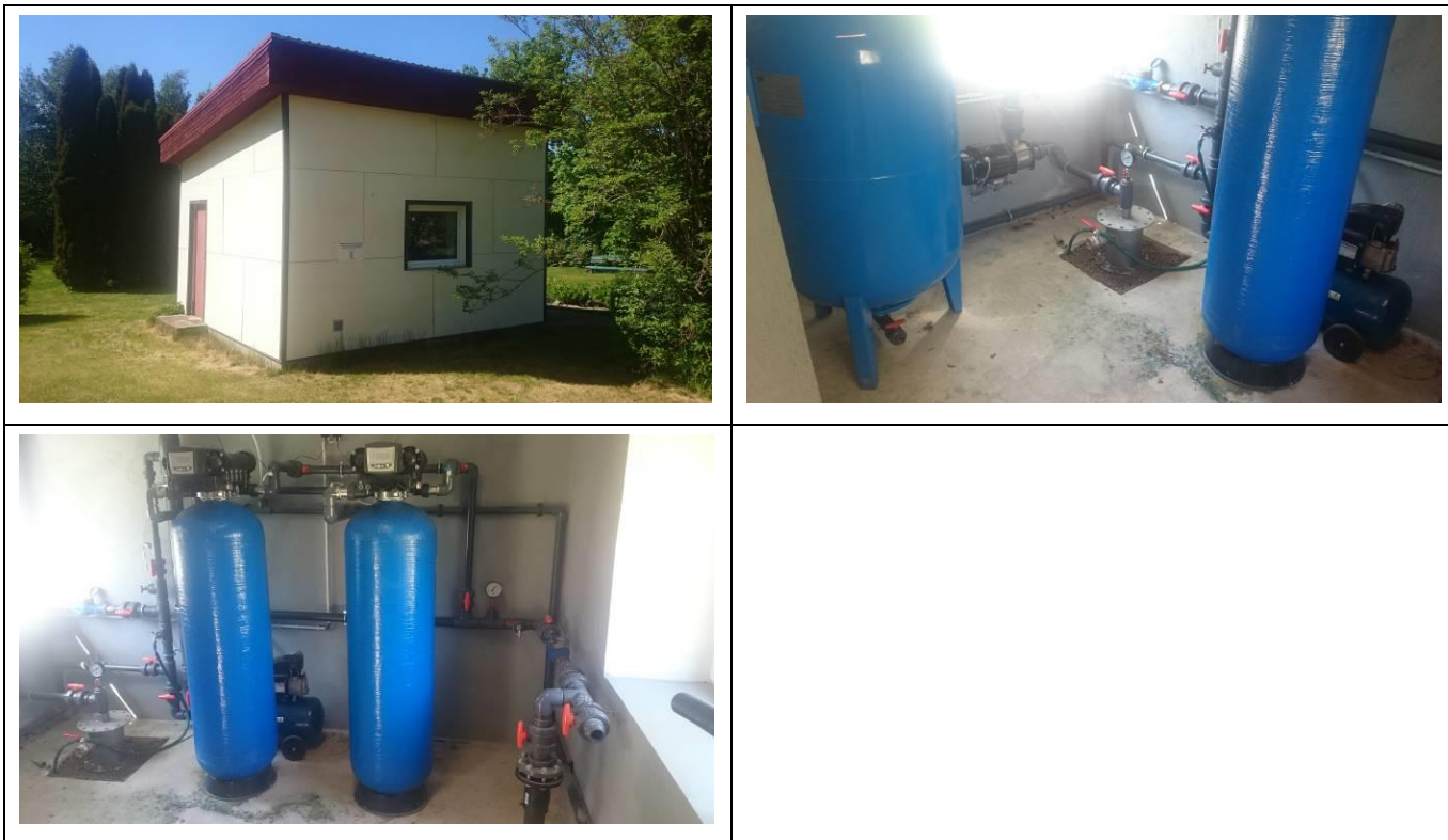
Joonis 4. Häädemeeste aleviku Kooli puurkaev (katastri nr 6564) ning veetötlusjaam. Fotod: OÜ Alkranel 21.05.2018.
