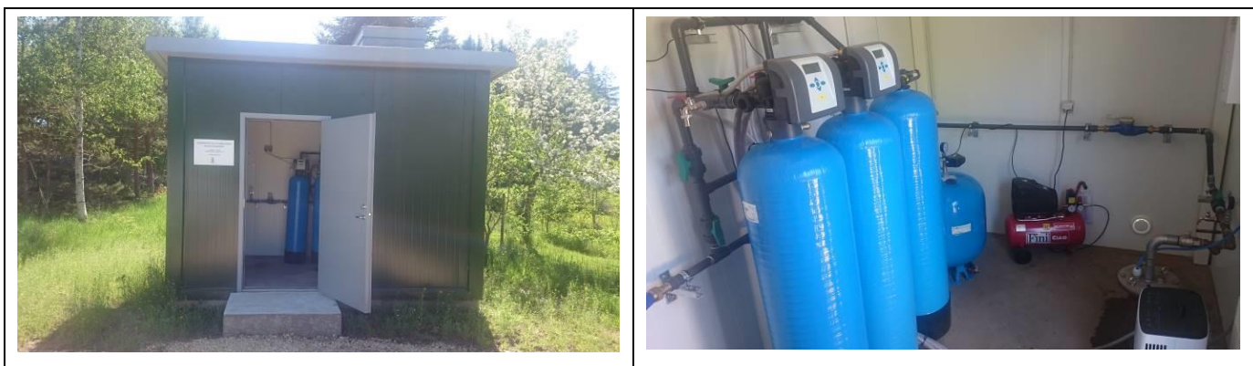
Joonis 32. Soometsa puurkaev (katastri nr 6677) ning veetöötlusjaam. Fotod: OÜ Alkranel 21.05.2018.
