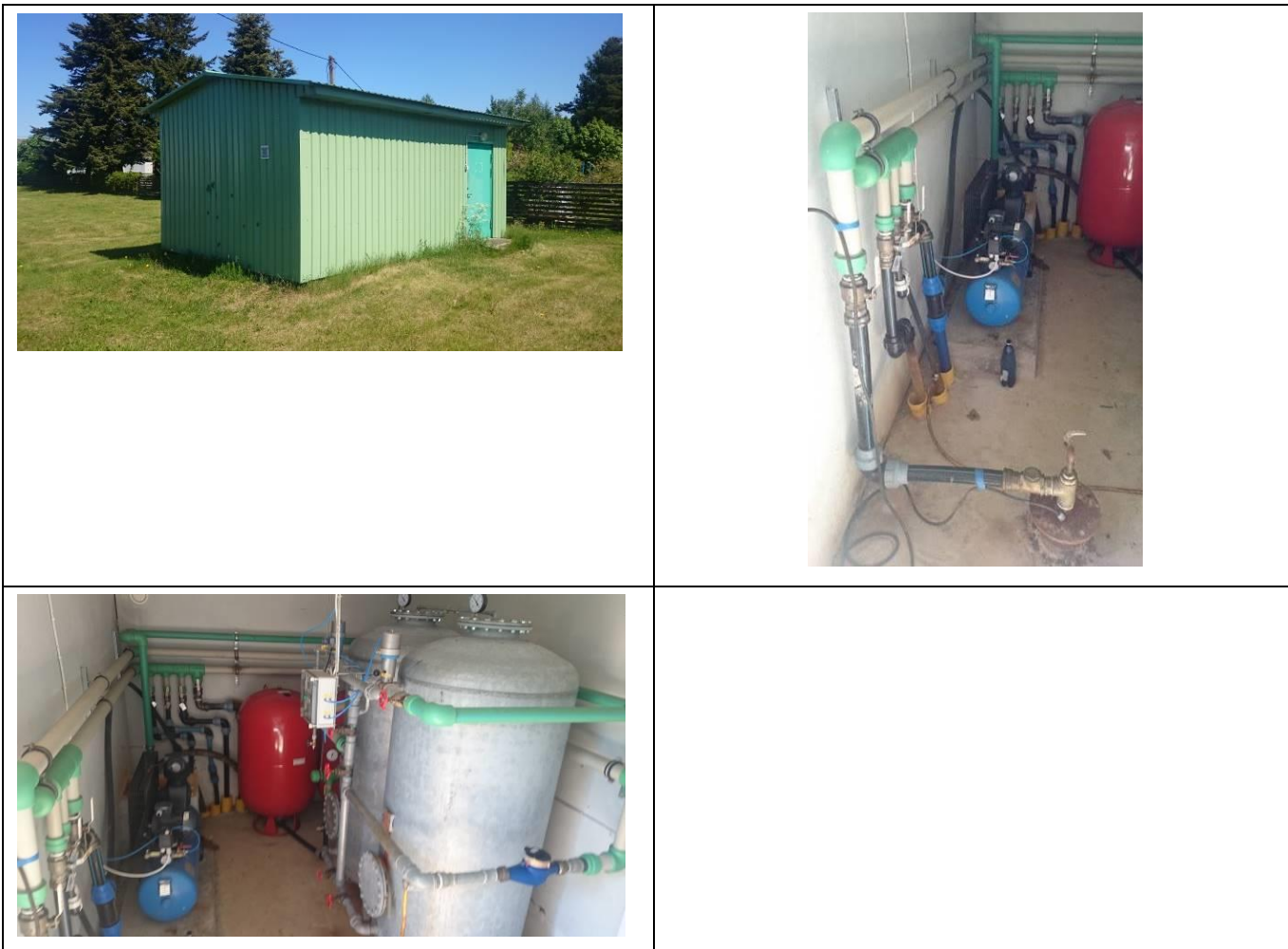
Joonis 13. Võiste aleviku Külmhoone puurkaev-pumpla (katastri nr 6459) ja veetöötlusjaam. Fotod: OÜ Alkranel 21.05.2018.
