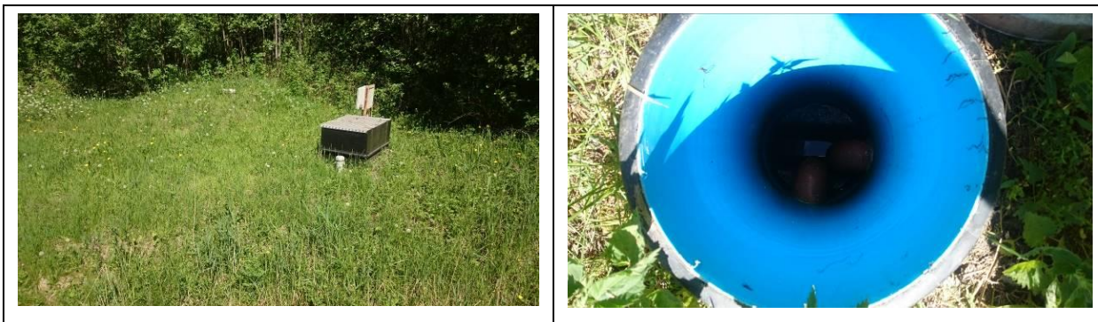
Joonis 17. Reiu küla Kulla tee reoveepuhasti. Fotod: OÜ Alkranel 21.05.2018.
