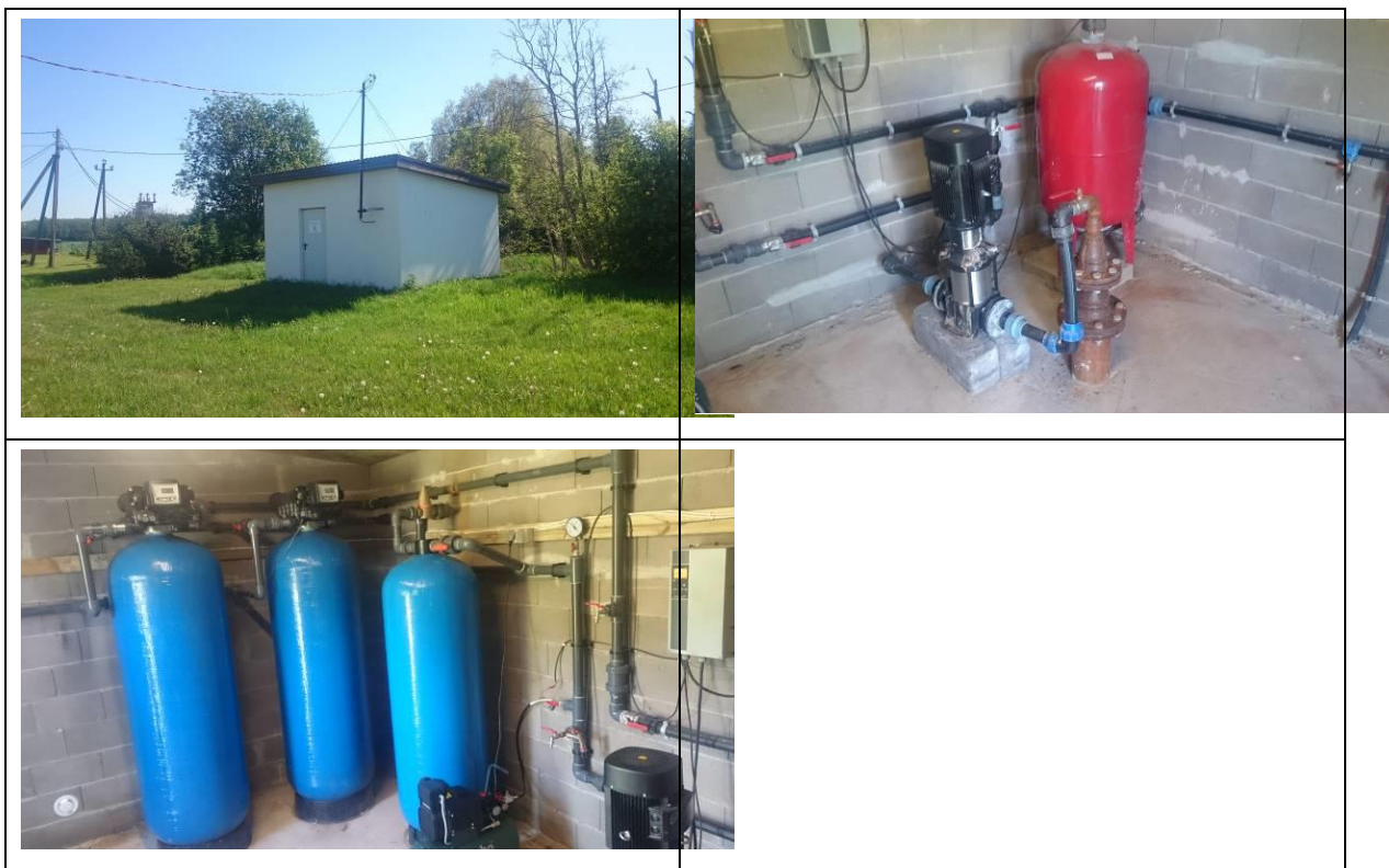
Joonis 20. Kabli küla puurkaev (katastri nr 6571) ning veetöötusjaam. Fotod: OÜ Alkranel 21.05.2018.
