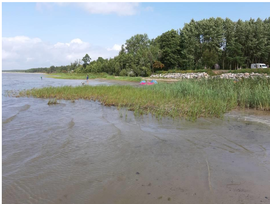
Foto 2.8. Vaade kirde suunas madalast veest. Liivarand on suures osas kaitstud kõrkjastikuga. Avatud osa nõlv on kindlustatud graniitkividega.
