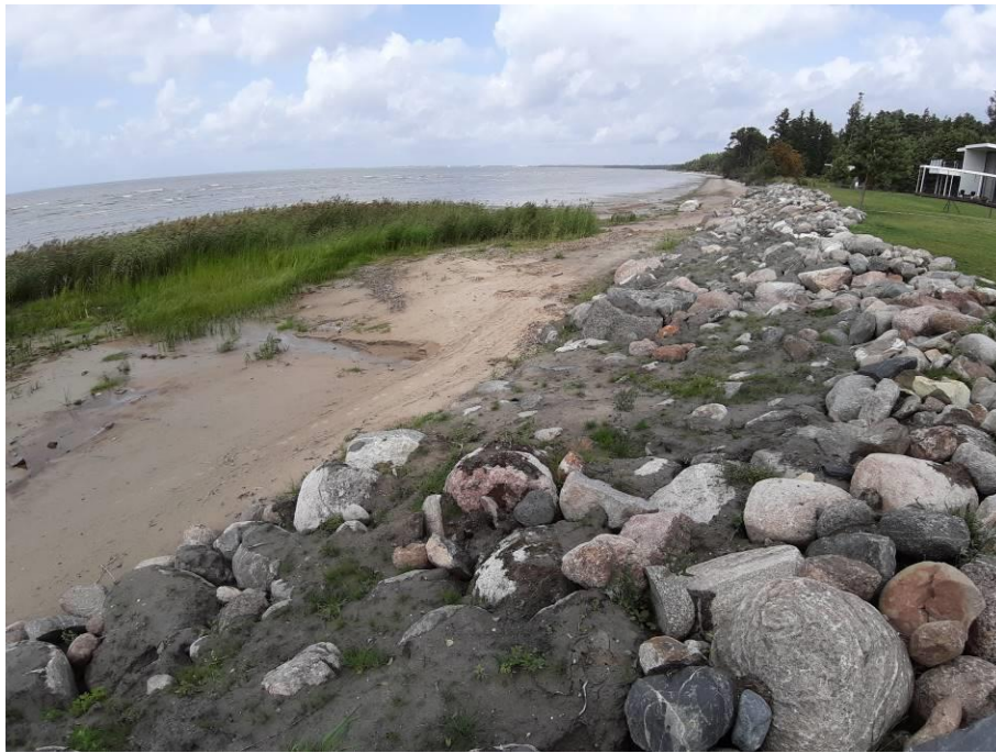
Foto 2.5. Vaade Kulla tee 7 kinnistu lõunapoolsest osast põhja poole. Ida pool on näha graniitkividest nõlvakindlustust, mida on ilmselt pinnasega kaetud, tekitamaks looduslikuma välja nägemisega pinnamoodi. Osaliselt on kinnistu ees näha kõrkjaid ja kõrgemat rohtu, mis takistaks liiva kandumist sügavamale vette, kuid ei väldiks kõrgvee ajal nõlva uhtumist.
