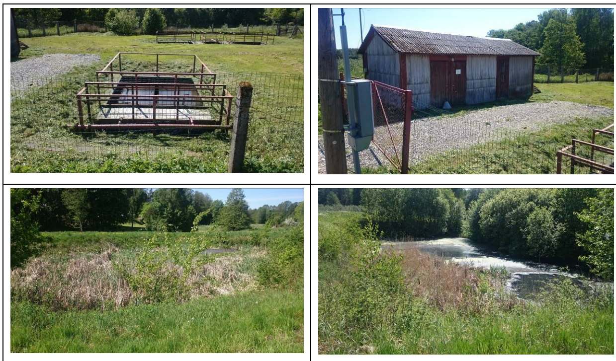
Joonis 11. Uulu küla reoveepuhasti. Fotod: OÜ Alkranel 21.05.2018.
