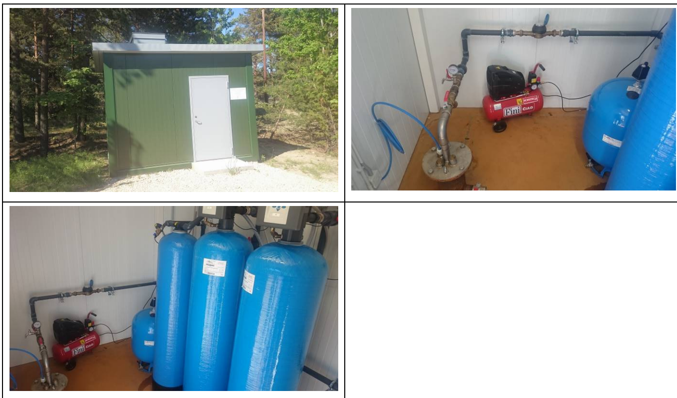
Joonis 23. Treimani Klubi puurkaev (katastri nr 7718) ning veetötlusjaam. Fotod: OÜ Alkranel 21.05.2018.
