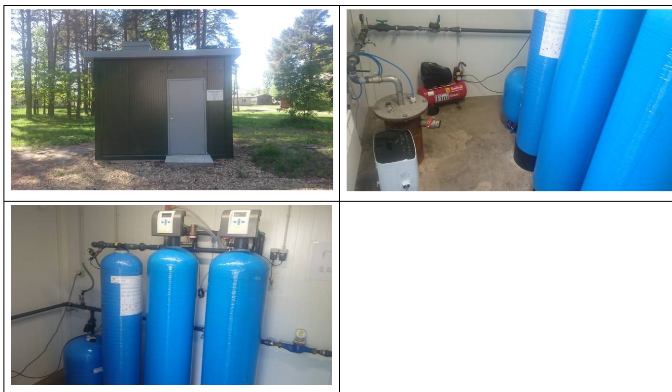
Joonis 5. Hädemeeste aleviku Teemeistri puurkaev (katastri nr 6563) ning veetötlusjaam. Fotod: OÜ Alkranel 21.05.2018.
