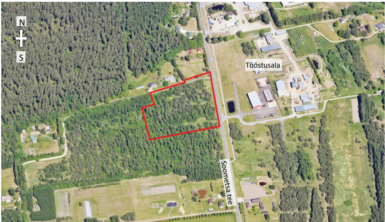
Skeem 1. Vaade planeeringualale lõunast. Planeeringuala on tähistatud punase joonega. Foto: Maa-ameti fotoladu, pildistatud 09.06.2023.
