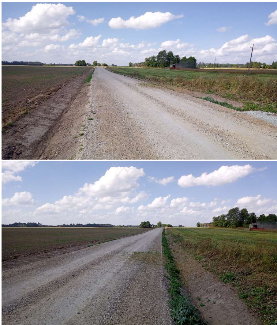
Joonis 11.3. Riigimaanteel taastatud kraavid (näited)
