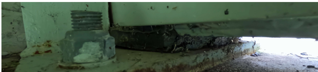
Joonis 6.7. Uulu-Kanali jalakäijate silla tugiosa
